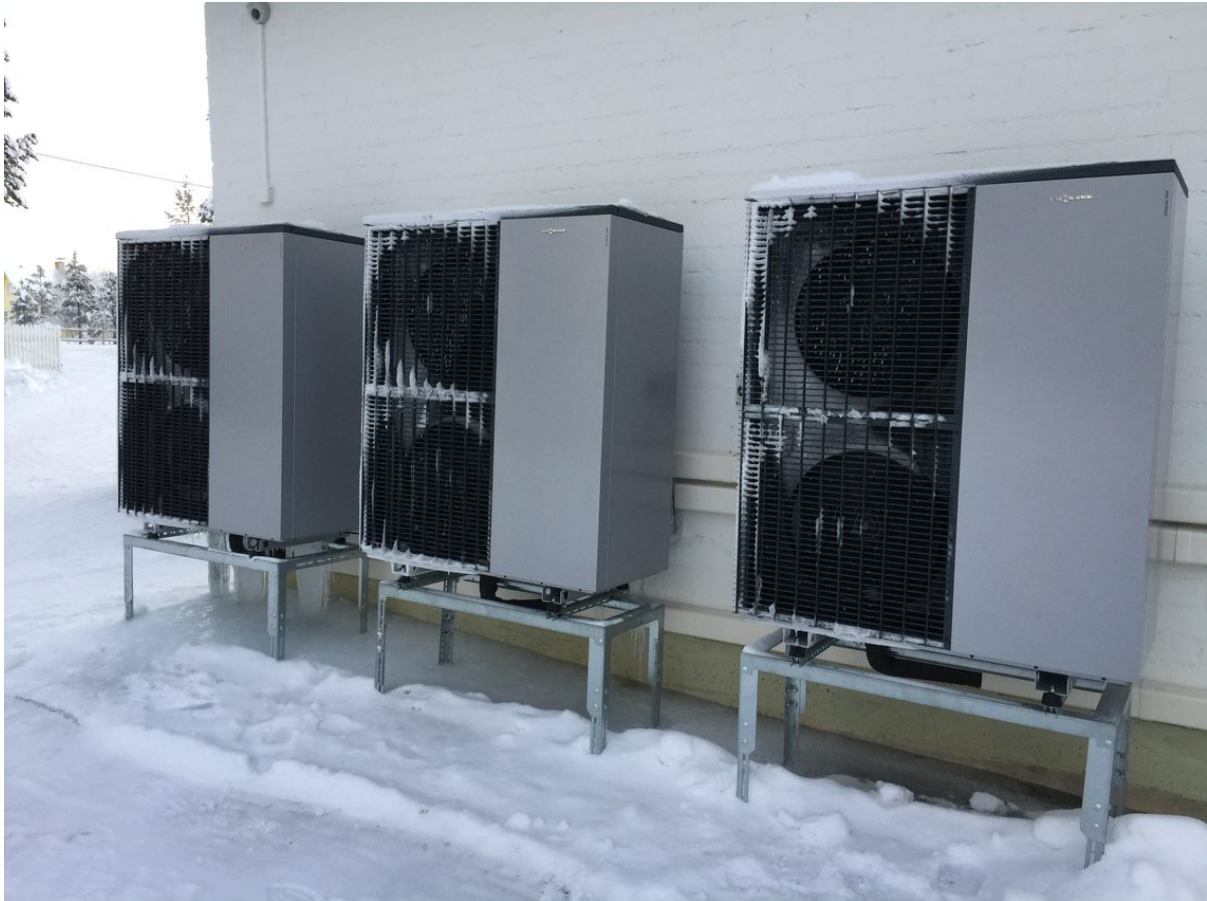
Kuva 1: Lämpöpumppujen ulkoisiköt
