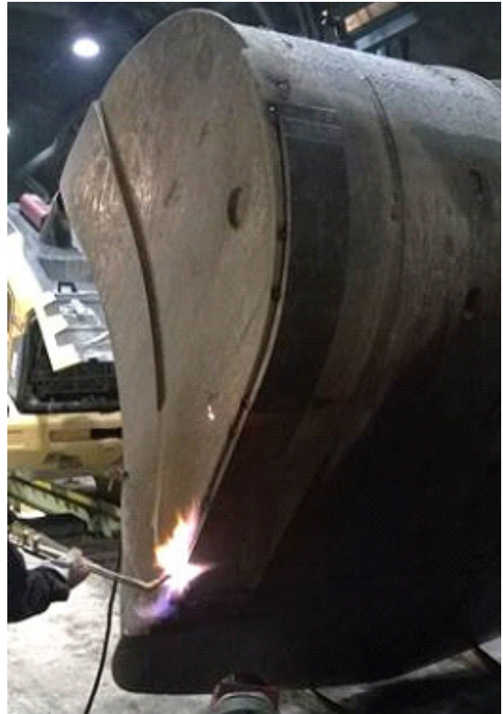
Kuva 5. Vasemman puolen levyjen paikalleen hitsausta
