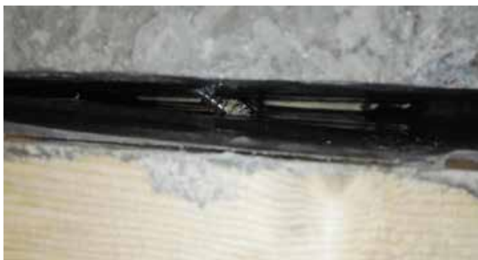
Kuvio 16. Ruuviliittimet vetäytyneet irti puusta
